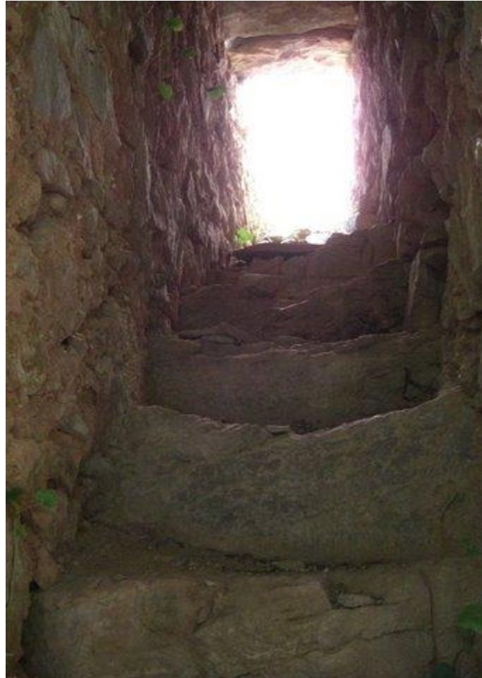
Escaleras para el acceso al pozo.
