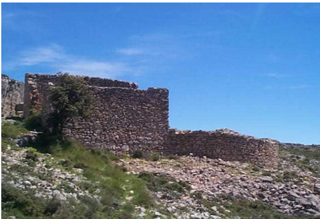
Depósito de planta circular, de 8,7 m. de diámetro con muros de 1 m. de anchura.
