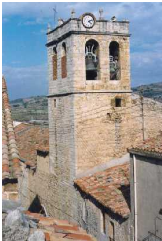
Torre del campanario
