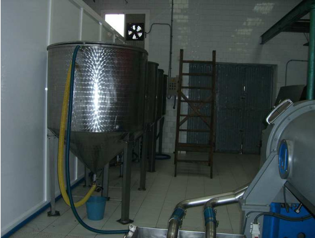
Depósitos de almacenamiento de aceite
