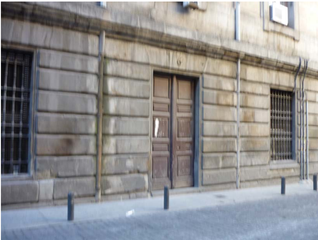
Antigua entrada por la calle Aduana
