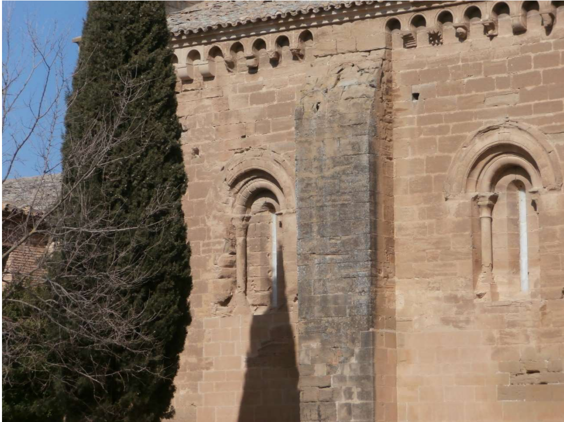
Ventanas exteriores de la iglesia.
