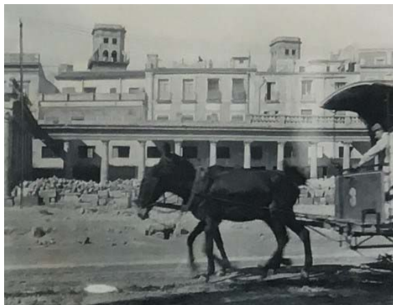
Fotografía 8. Derribo del antiguo mercado, año 1912. Fuente: Archivo municipal de Alicante.
