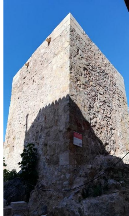
Torre vigía del pueblo restaurada
