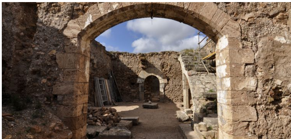
Obras de restauración del castillo de Petrés
