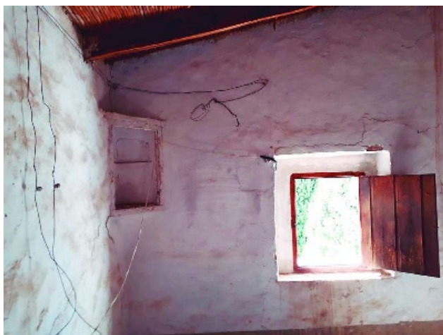
Vista del interior la casa de la Ermita en recostrucción
