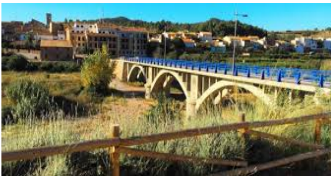
Puente sobre el Río Palancia
