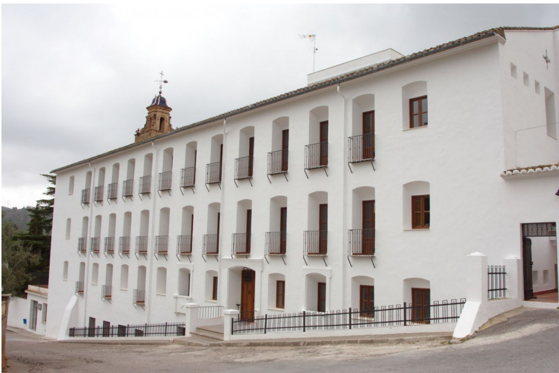
Vista de una de las fachadas del Monasterio
