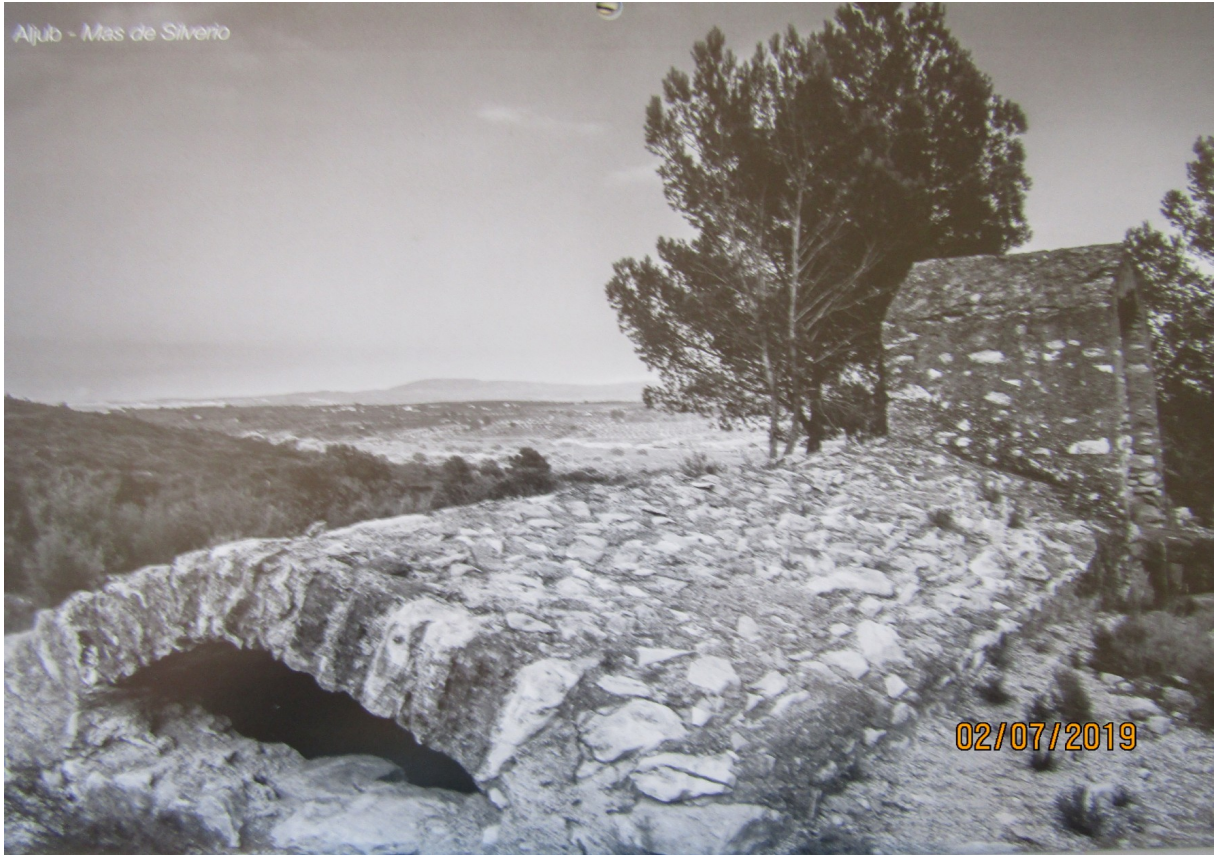
Aljibe semienterrado desde el exterior
