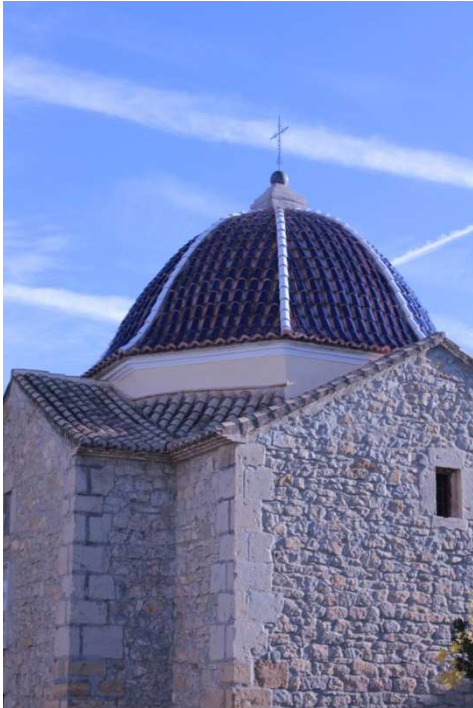
Cúpula del camarín, también restaurada exteriormente restituyendo las tejas vidriadas tal como eran.
