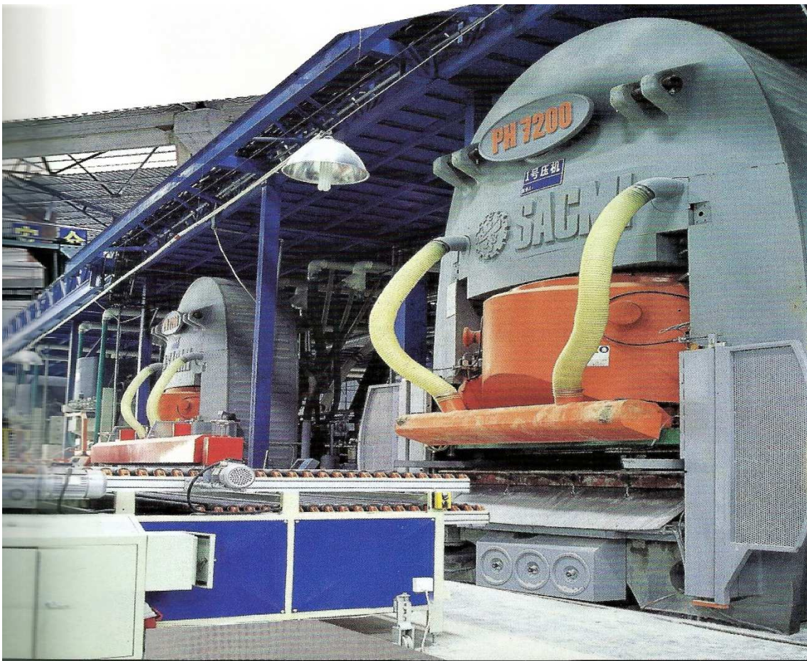
4. Sección de Prensas de una planta actual.
