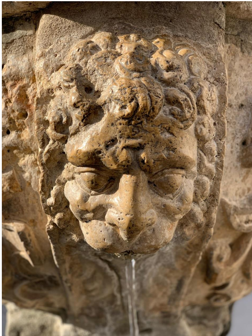
55.- Detalle de los caños de la Fuente y la cabeza de los leones. Originalmente, el chorro de agua manaba de un caño de bronce que sobresalía alrededor de 15 cm. de la escultura.
