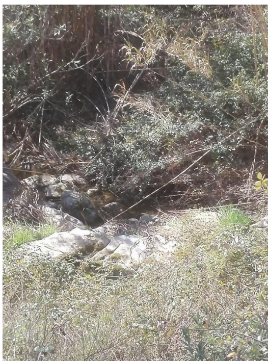
2.- Restos del antiguo puente en el cauce del Palancia.
