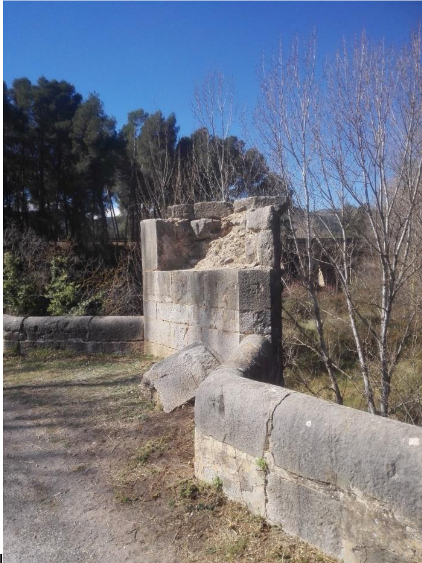
7.- Pilar central del Puente en su parte Norte con el arrimadero.
