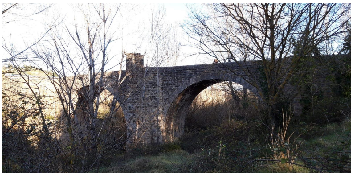
5.- Puente del Obispo Muñatones sobre el Palancia
