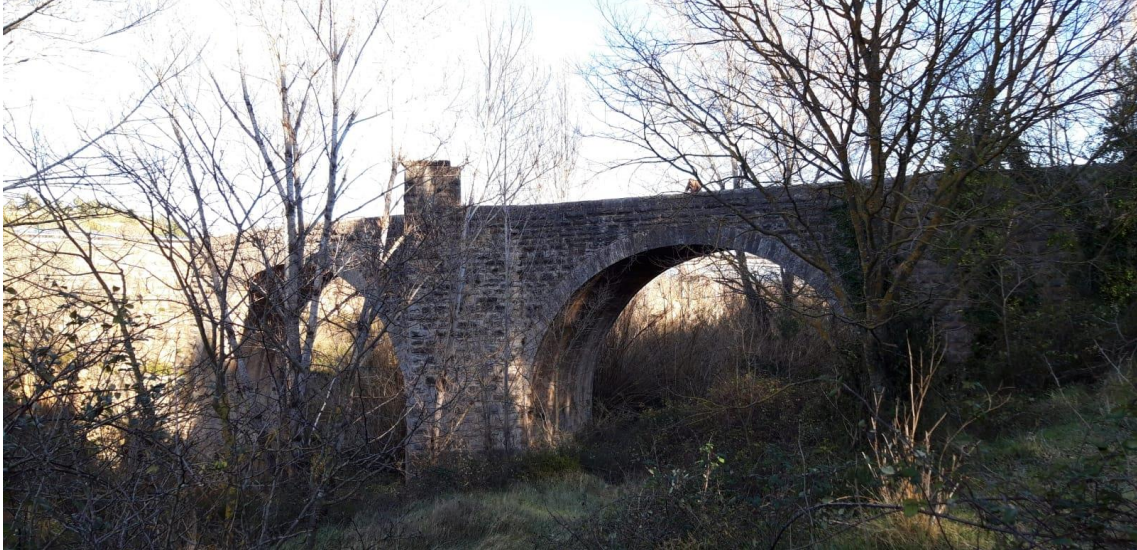
3.- Puente del Obispo Muñatones
