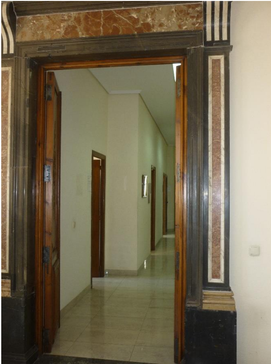
17.- Dintel de alabastro que da entrada a la zona de despachos. M a Teresa Ferré.
