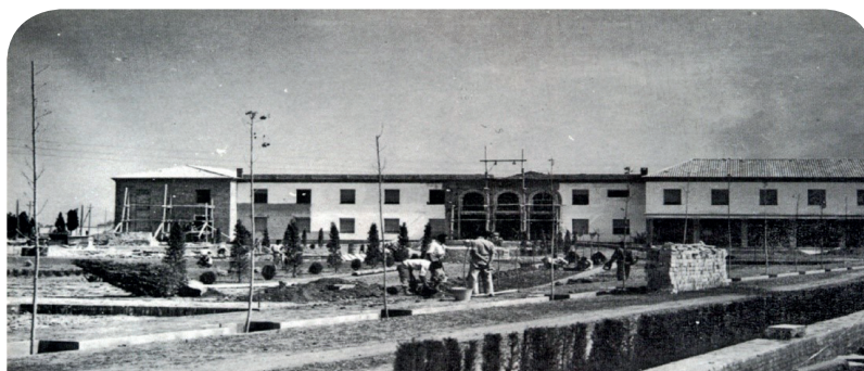
El sanatorio en obras
