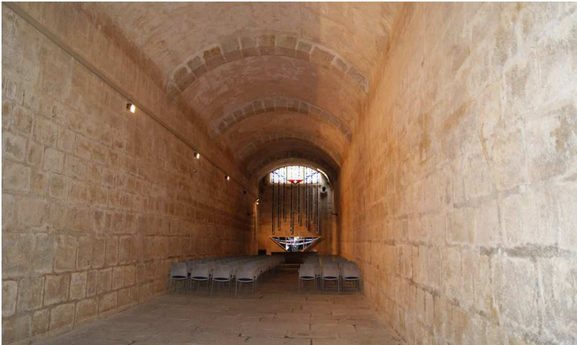
Vista interior cisterna del Vall
