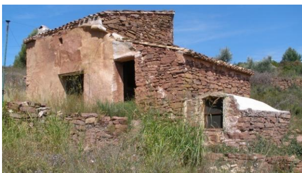
38. Aljibe junto a una caseta. Altura.
