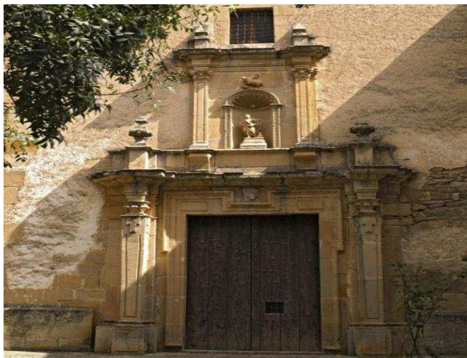
Fachada principal de la iglesia
