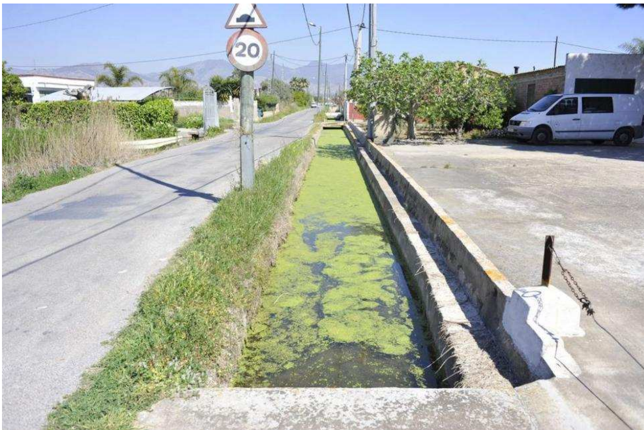
Camí de la 1ª Travessera y acequia de la Fileta
