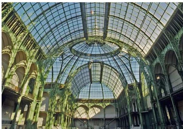
(paddock), la cúpula sobre los colgantes y la cúpula pesan unas 8.500 toneladas de acero, hierro y vidrio. El peso total del metal utilizado es de 9 057 toneladas (contra 12 000 para la estación de Orsay y 7 300 para la estructura de la Torre Eiffel). La cima de este conjunto culmina a una altitud de 45 metros.
