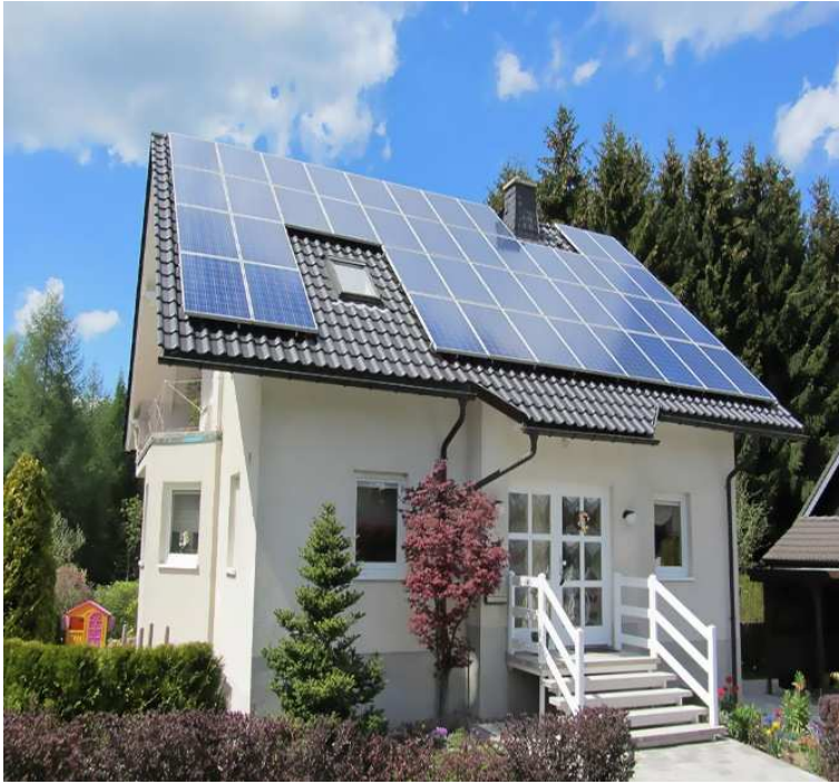
Fig. 10 Casas dotadas de placas solares
