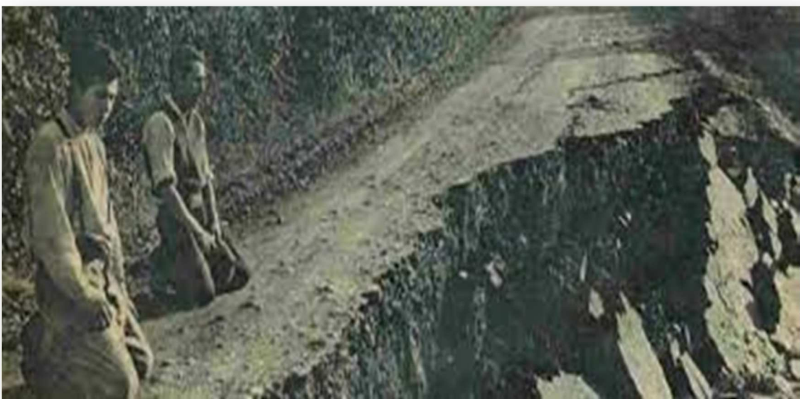
Grietas de más de 5 metros de ancho causadas por el Terremoto de 1755
