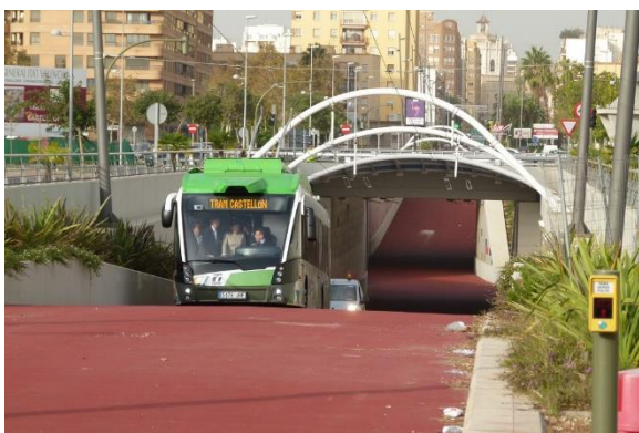
22 Izquierda. El Paso inferior del Tram el día de la inauguración con el túnel exclusivo al fondo y Derecha. Paso inferior de la Ronda Este bajo el Paseo de Lidón
