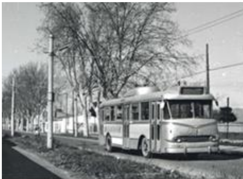
16 Trolebús en la carretera de El Grao.) Se observan los postes del tendido eléctrico.
