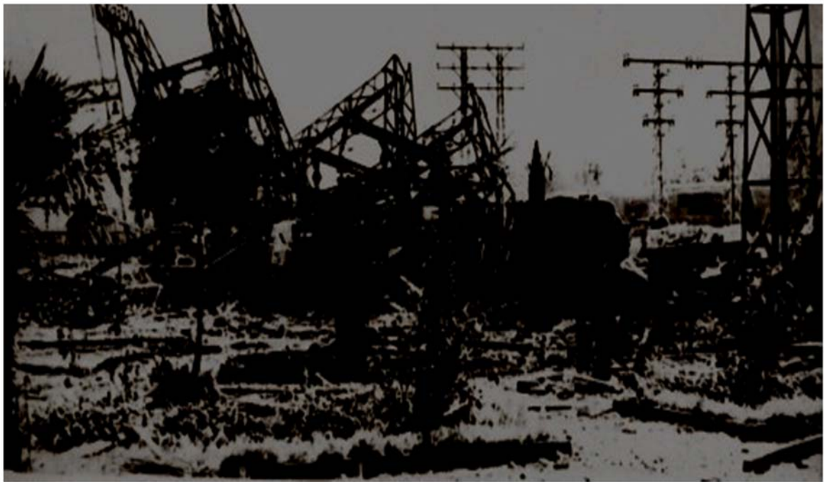
Subestación eléctrica de Castellón en la avda, Hermanos Bou volada por las tropas republicanas de Castellón en junio 1938
