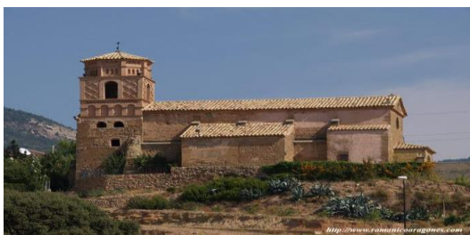
Vista lateral Iglesia
