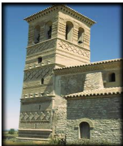
Torre iglesia S. Pedro
