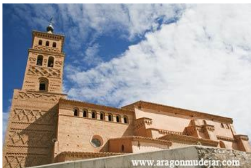
Vista frontal torre e iglesia
