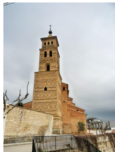
Vista lateral conjunto
