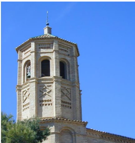
Detalle decoración Torre
