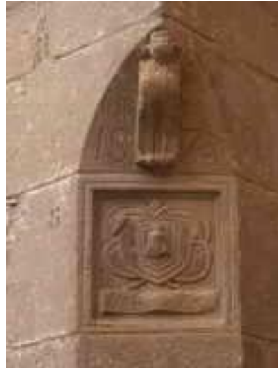
Detalle esquina muro
