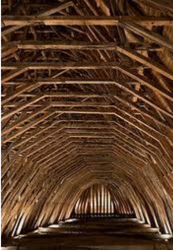
Armadura a dos aguas
