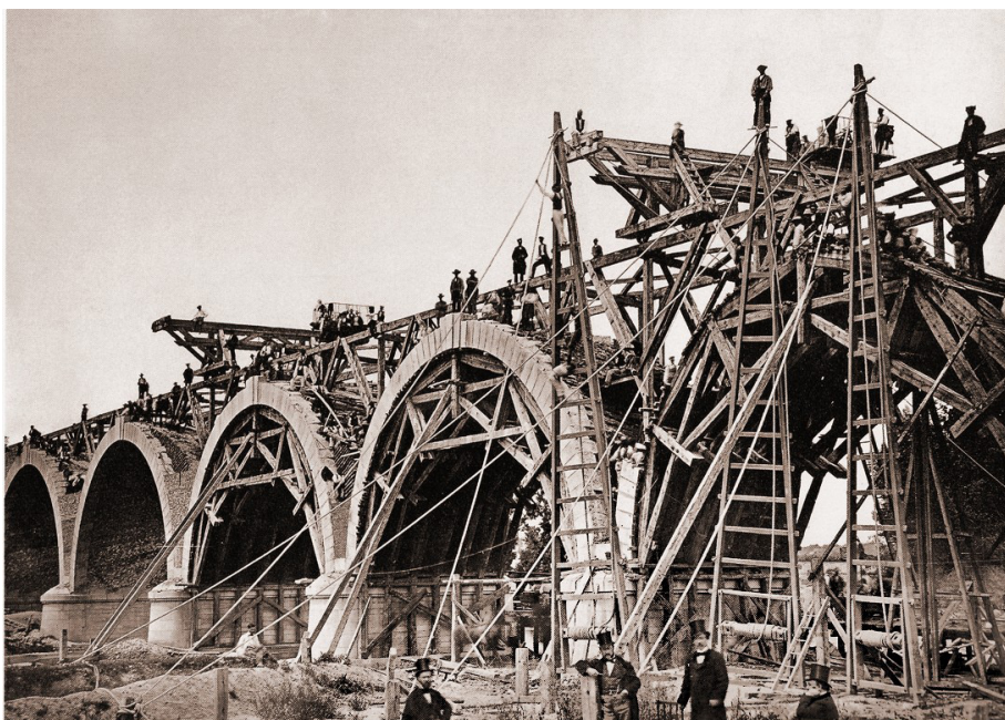
Construcción del puente de los Franceses, siglo XIX.
