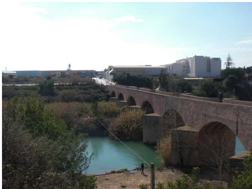
Puente de Santa Quiteria
