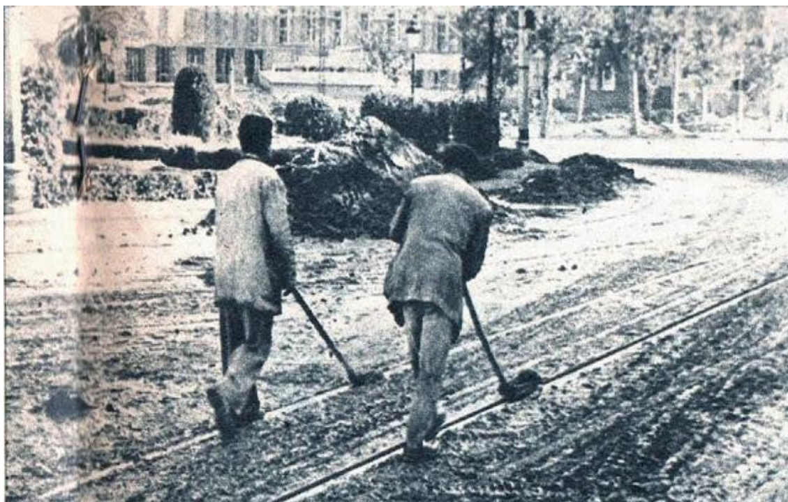
1957. Las vías de los tranvías siempre tenían que estar limpias por si una piedra se metía en el carril y lo hacía descarrilar. Se les llamaba peritos limpiavías. A veces en la vía había incrustadas piedras y si veis la posición de los hombres llevando el mando de madera, apoyado en el estómago o el vientre, al final tenía una pieza de hierro con una lengüeta que se introducía en la vía y la limpiaba.
