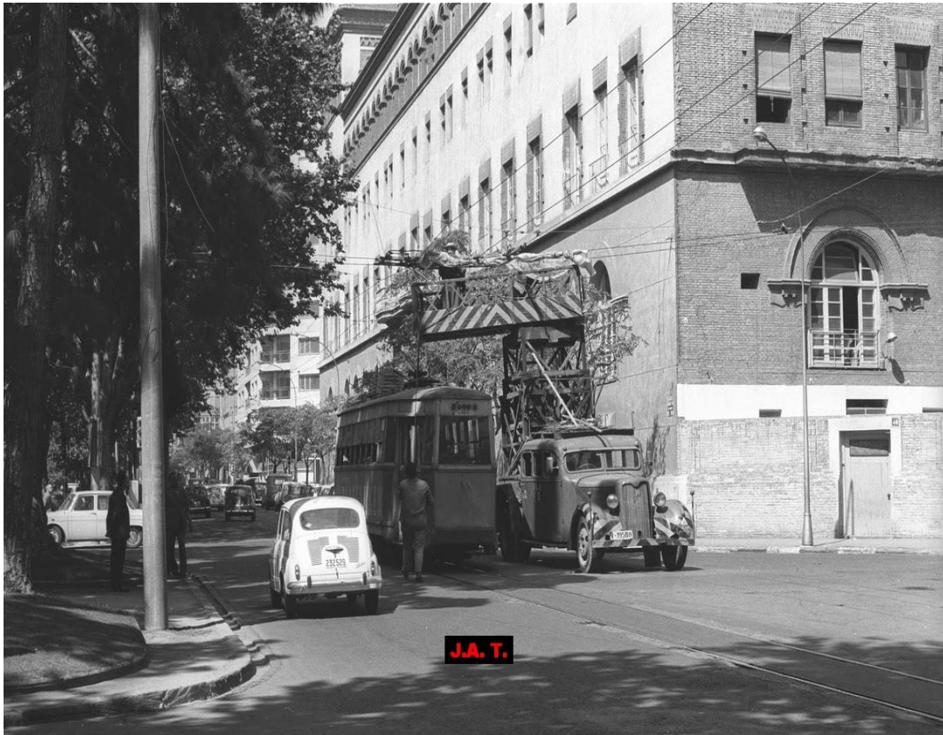
Ahora pasa un tranvía. Basta un operario para mantener el trole separado de la vertical de la línea aérea.
