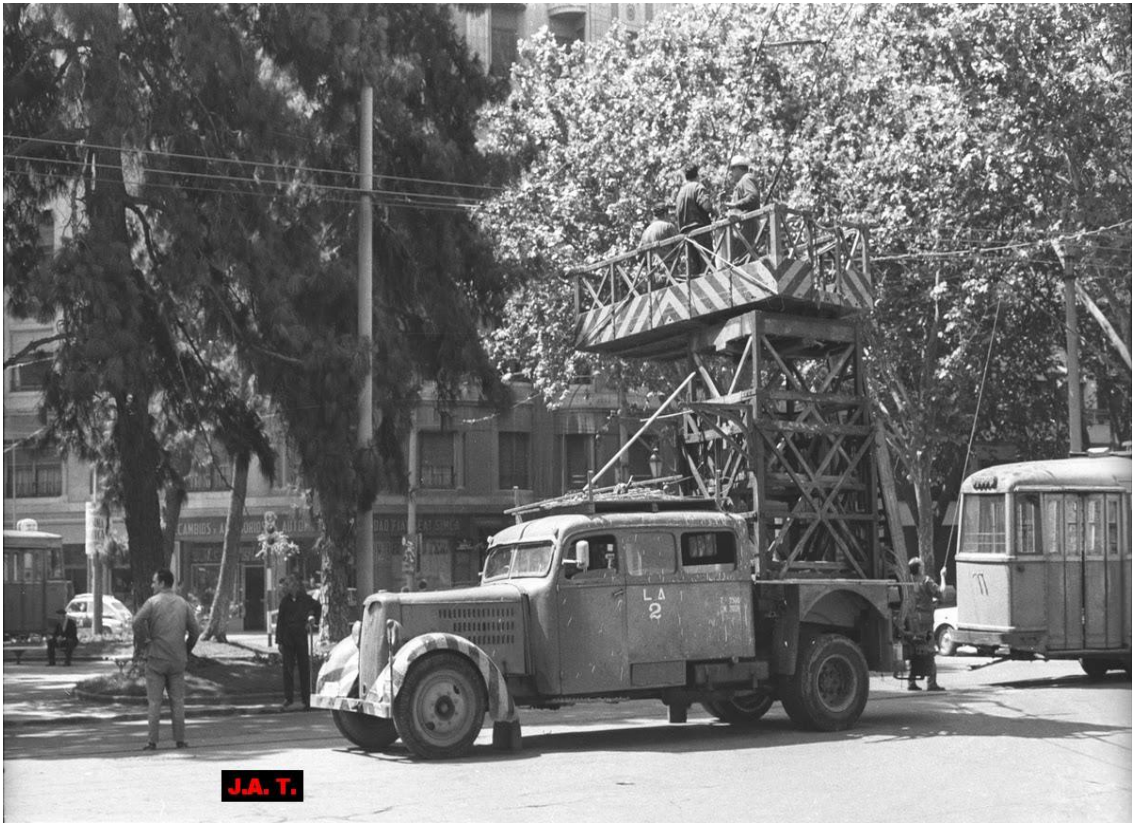
8/6/1970. Vehículo especial para arreglo de catenarias
