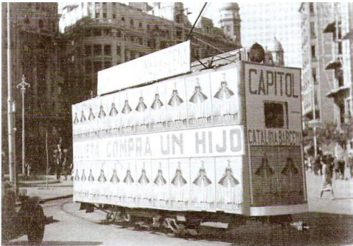
Nueva técnica utilizada por la empresa Pechuán para dar a conocer sus estrenos en los años treinta. A la derecha el futuro cine Rialto en plena construcción.
