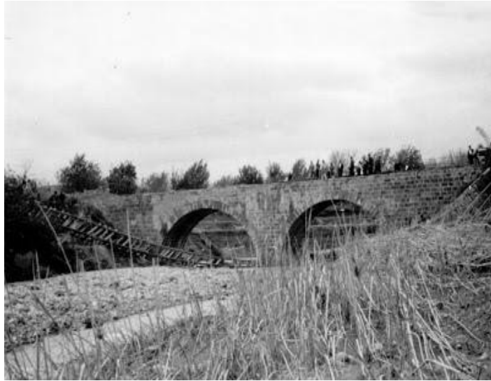
telegráficas con Valencia. Foto nº 10 Puente de la vía férrea.
