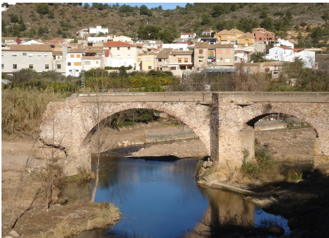
Foto nº 4. Vista actual de los restos del viejo puente.
