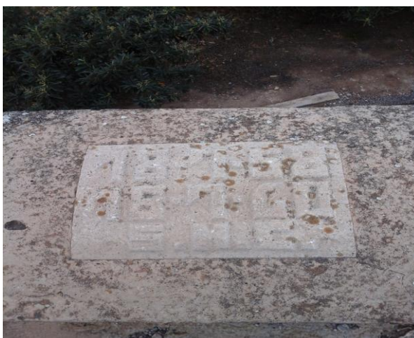
Foto nº5. Fecha sobre el pretil del puente.
