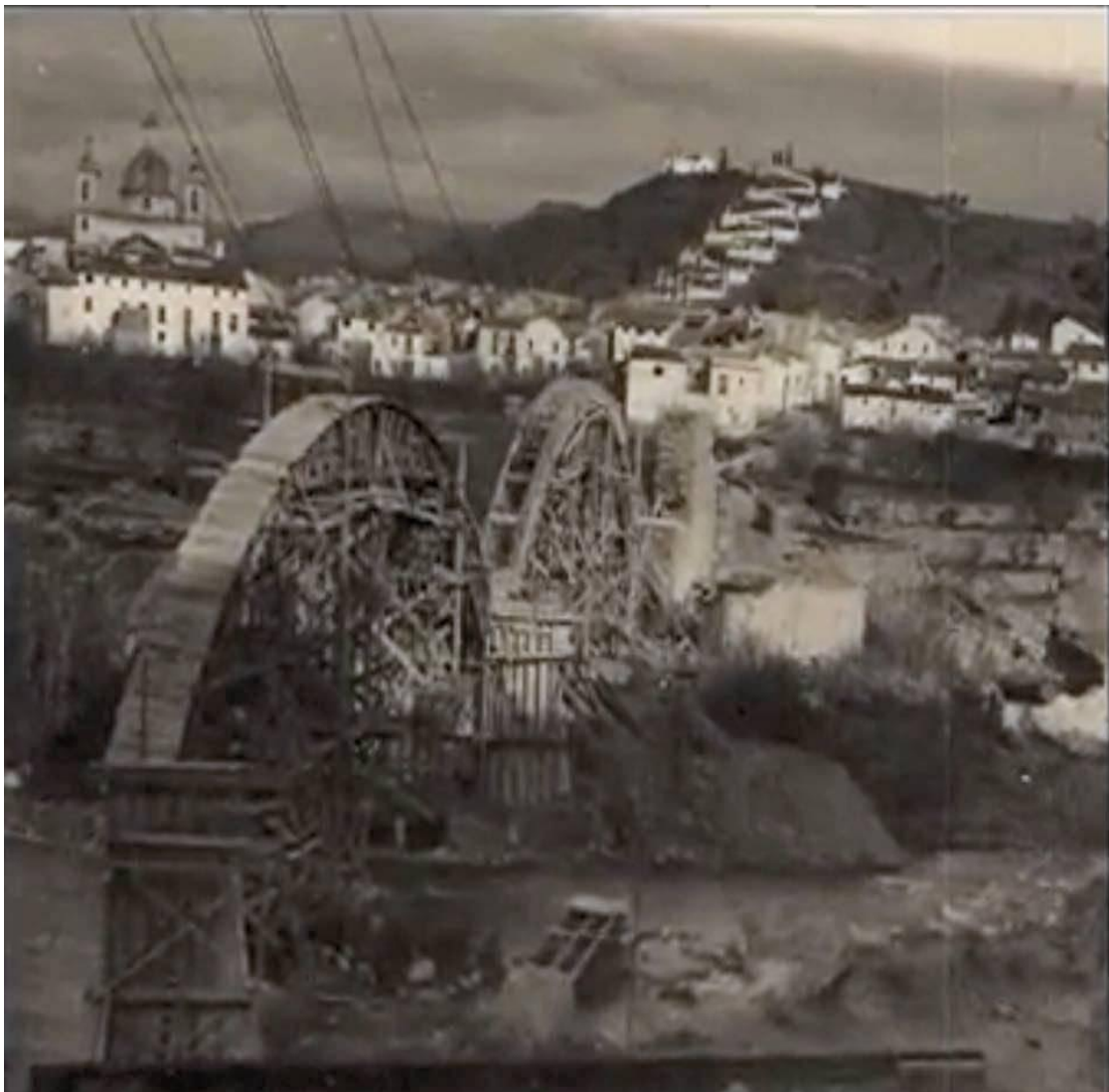
Foto nº 12. Comienzo de las obras del nuevo puente en Sot de Ferrer.
