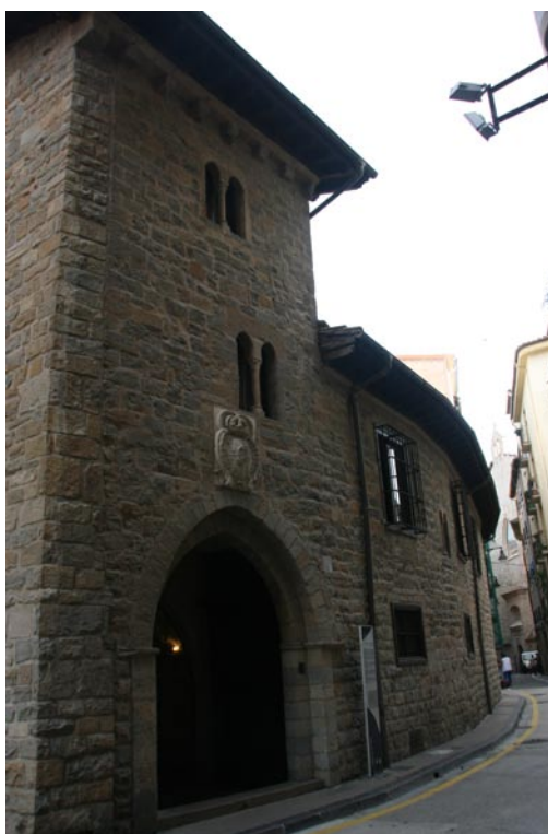
Imagen 24: Edificio de La Cámara de Comptos.
