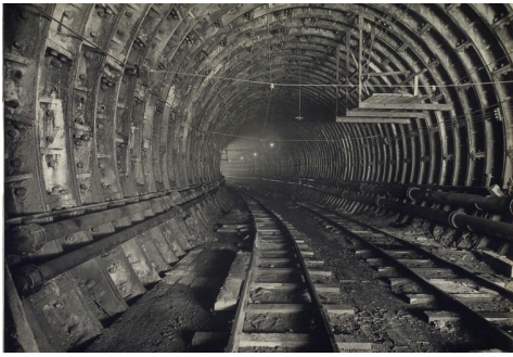
Túnel bajo el puente Holland
