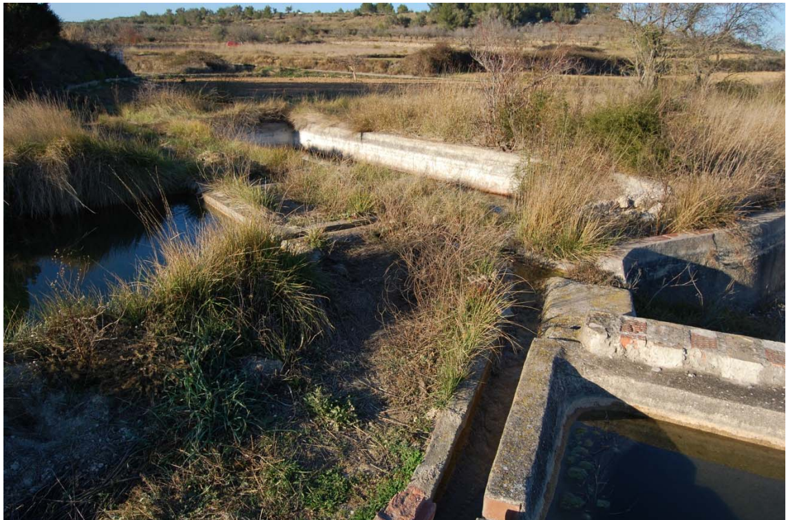
Imagen 10 y 11. Albercas tramo final cuarta peixera .
