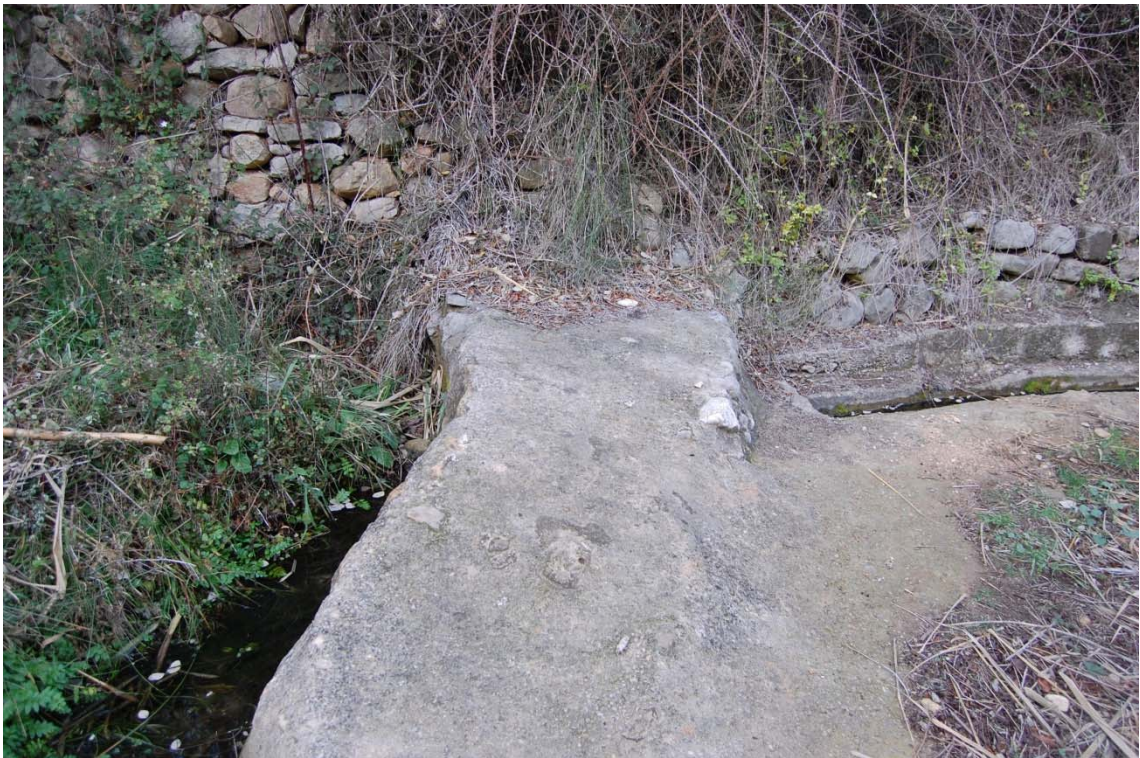
Imagen 7. Salida del azud hacia la canalización. Margen izquierdo
