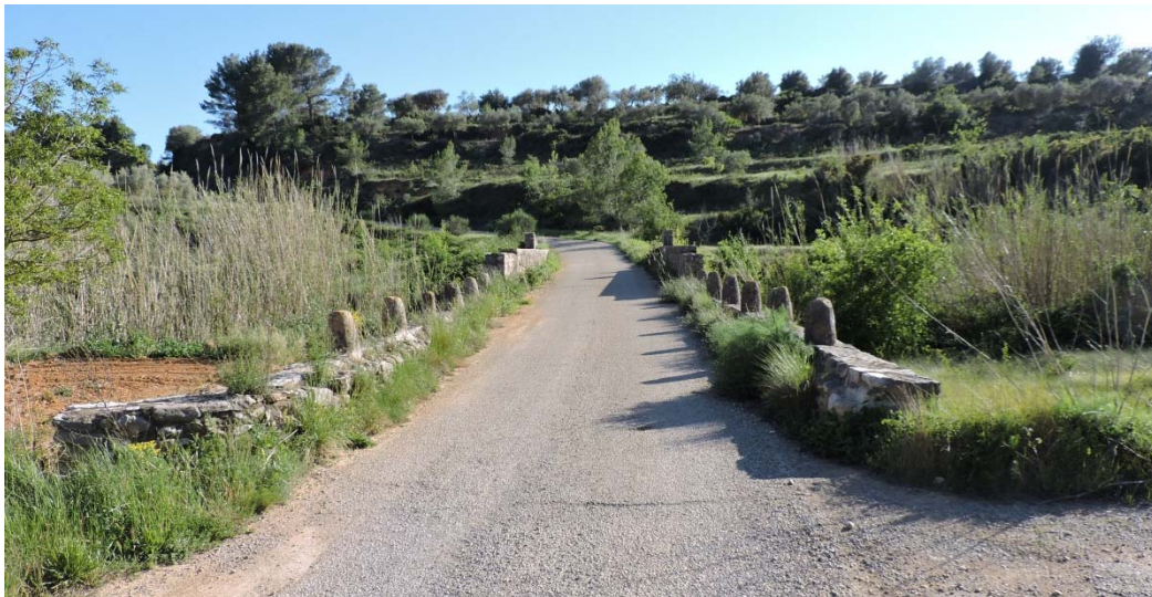
Imagen 1. Vista del Puente de la Coma .
