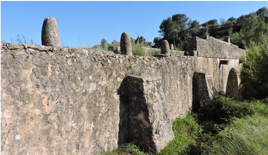
Imagen 2. Vistas laterales del Puente de la Coma .
