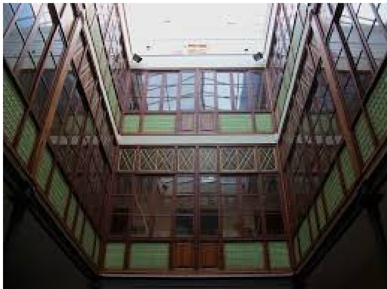
Pati interior de la casa dels Caragols
