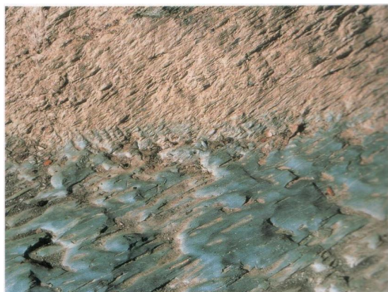
Erosión causada por el paso del agua Canal de Peña Escribida
