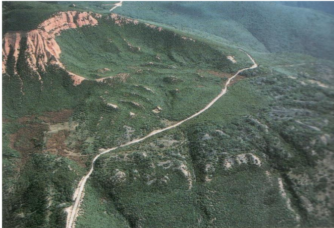
Canales de evacuación en la zona de La Llagüa de Yeres
