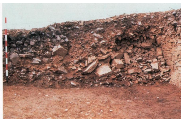
Derrumbe de la muralla de la Corona del Cerco de Borrenes
