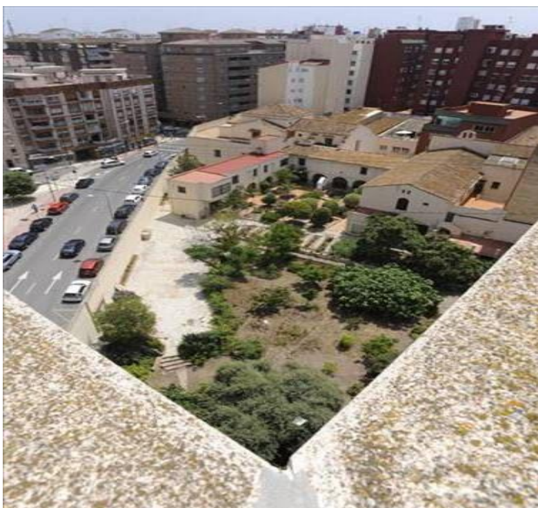
Vista del convento esquina calle Gobernador
