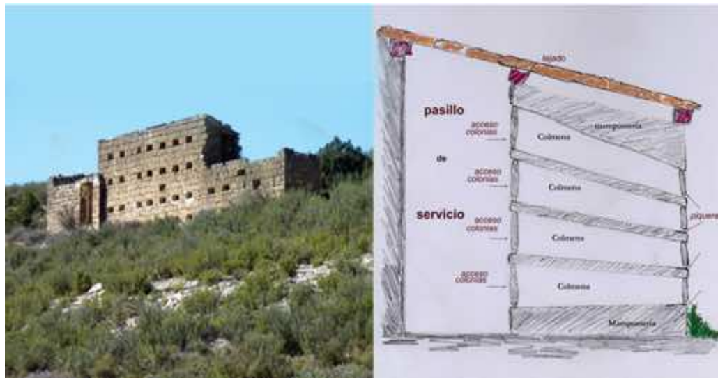
1.16 A l'esquerra aspecte actual d'un antic arnar a l'Aragó. A la dreta un esquema de la distribució interior de la construcció
